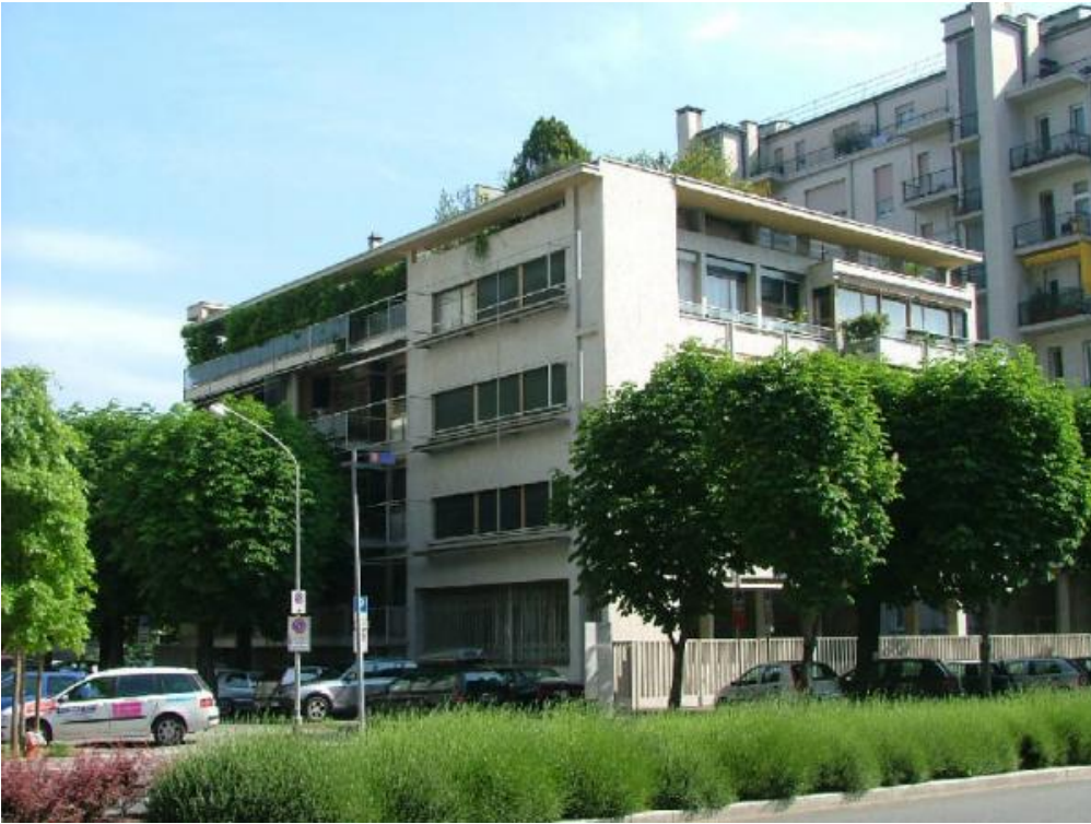
Casa ad appartamenti Giuliani - Frigerio a Como
