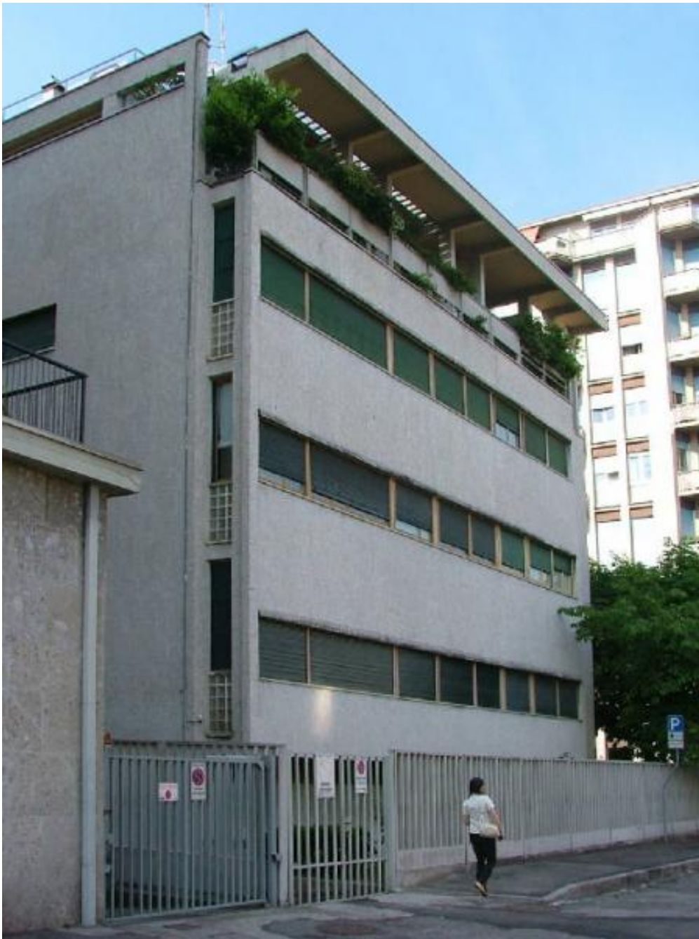
Casa ad appartamenti Giuliani - Frigerio a Como
