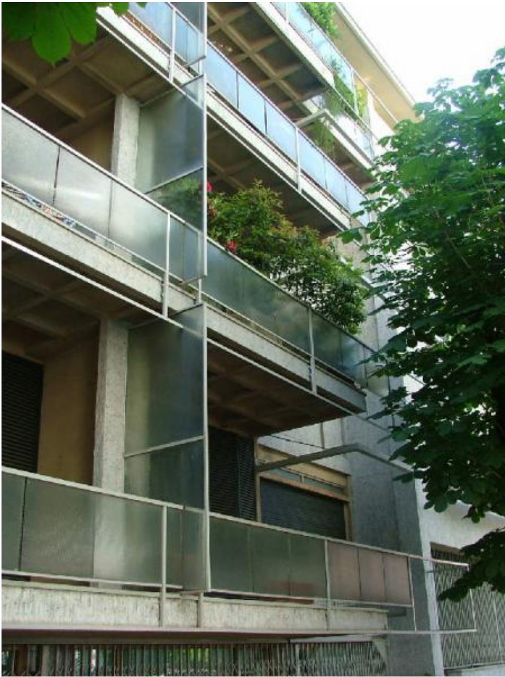
Casa ad appartamenti Giuliani - Frigerio a Como
